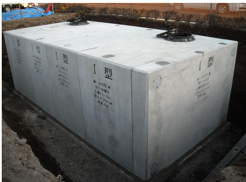
耐震性貯水槽（I型 組立状況）
