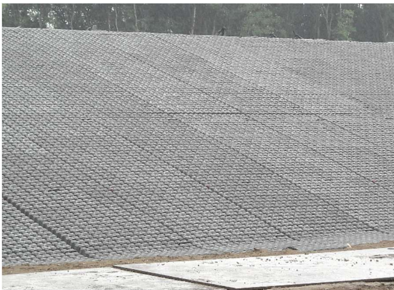
ーソルコマット(標準タイプ) 施工例ー
